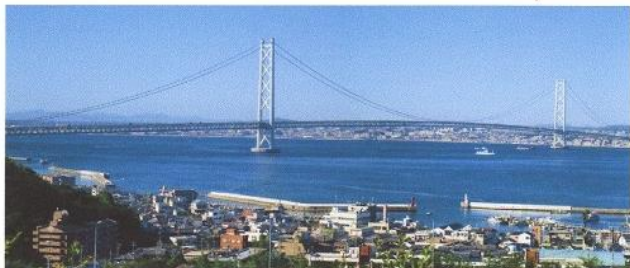
「明石大橋」淡路島側
